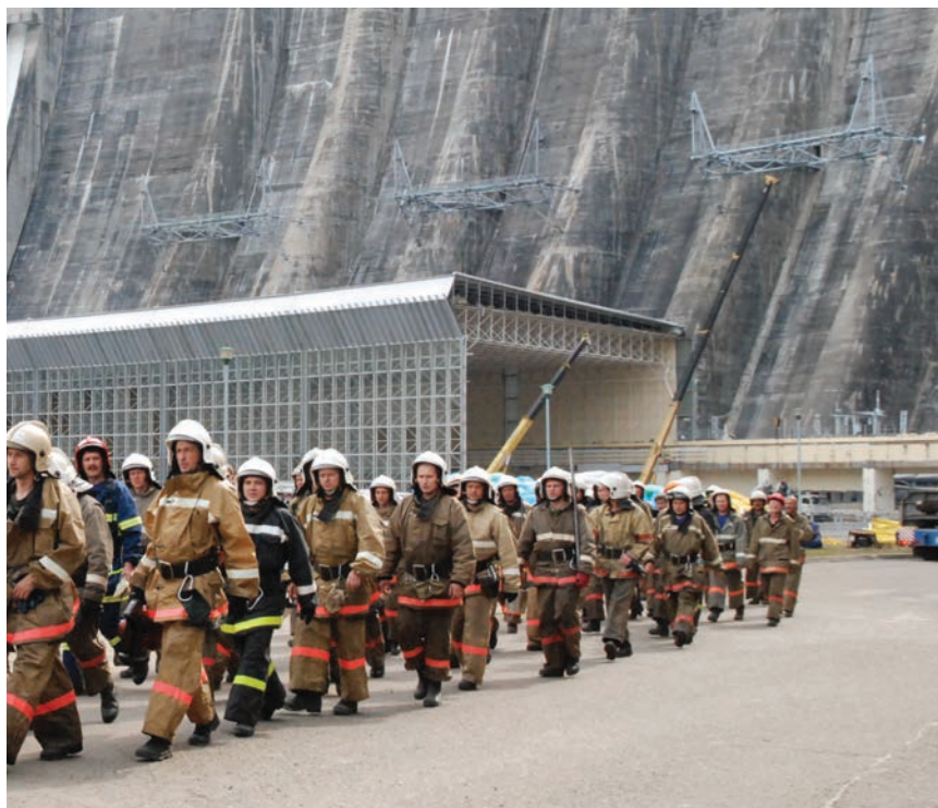
Авария на Саяно-Шушенской ГЭС.
